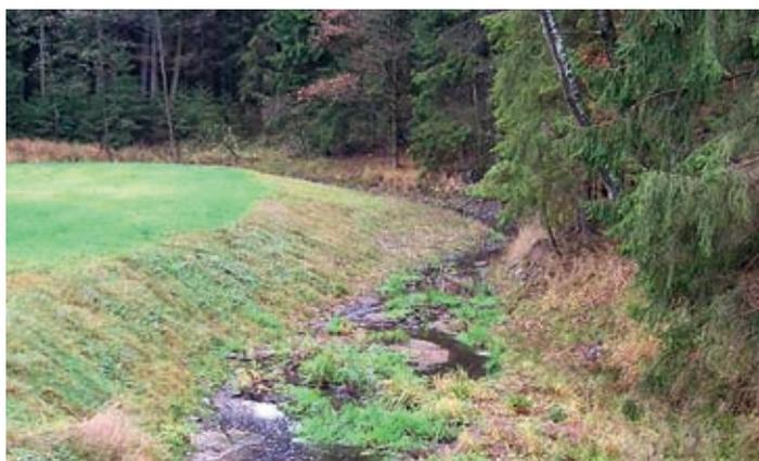
*Begrünte, flache Böschungen halten Hochwässern mehr stand als steile, mit Steinen gesicherte Ufer (Unterspülungsgefahr).*
