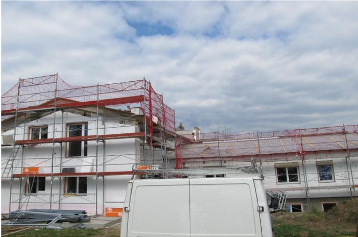
Nunmehr wurde der Zubau (Stiegenhaus und Liftschacht) im Rohbau fertiggestellt. Der Dachstuhl über dem Gebäude wurde erneuert. Ebenso schreiten die Innenarbeiten wie Herstellen der Installationen und Aufstellen der Zwischenwände voran. Die neuen Fenster sind ebenfalls eingebaut. Da der Bauzeitplan bis jetzt eingehalten wurde, lud der Bürgermeister zu einer Gleichenseier.
