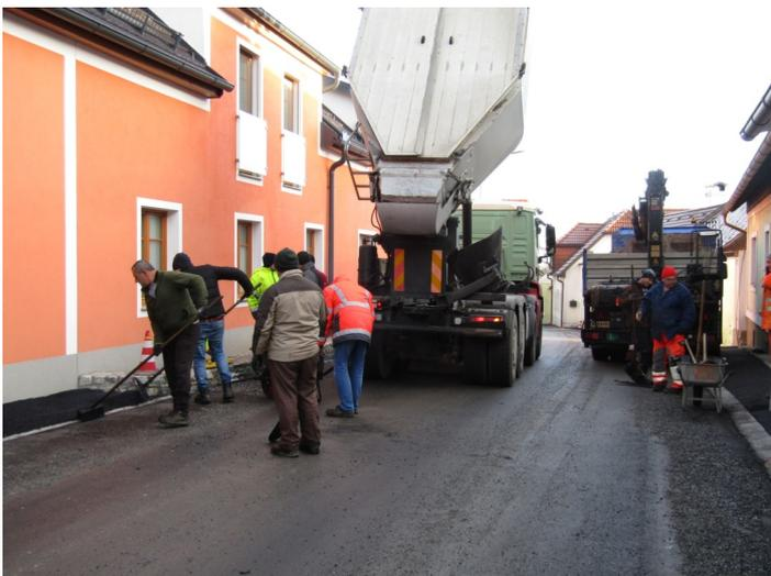
Über die gesamte Fläche von ca. 4.600 m<sup>2</sup> wurde abschließend eine 8 cm starke Tragschicht sowie eine 3 cm starke Deckschicht eingebaut. Die Verbreiterung in einem starken Kurvenverlauf mit Errichtung einer Absturzsicherung sorgt ab sofort für eine wesentliche Erhöhung der Verkehrssicherheit im Ortsgebiet.
